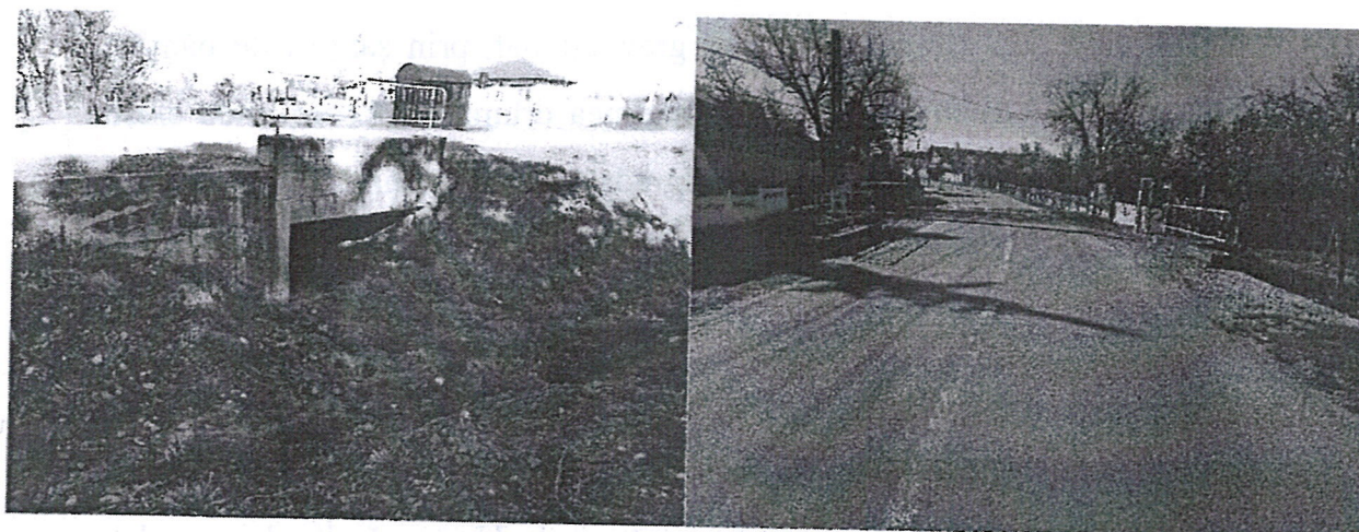
Podeț dalat în zona Scolii fără amenajări amonte-aval
