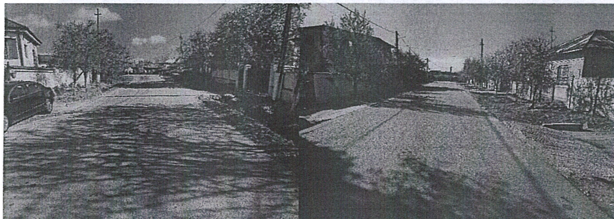
Șanțuri de pãmânt neprofilate, acostamente prãbușite, accese realizate în diferite variante de localnici
