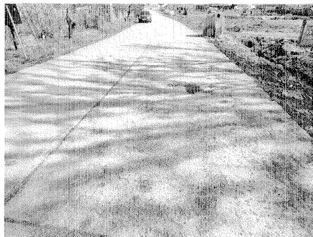
Suprafață exfoliata, acostamente din pamant
