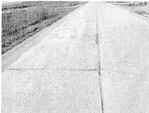
Suprafata exfoliata, rosturi deschise, colmate
